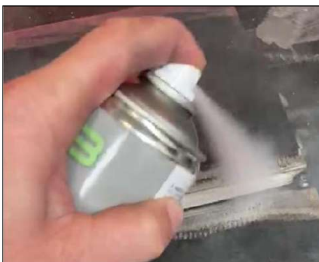
Applicazione del prodotto sul cianfrino prima della saldatura e dopo la prima passata
